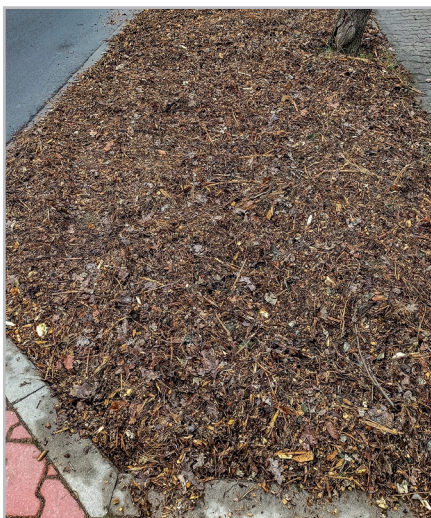
Część pasa drogowego, wypełniona wysokochłoną warstwą zrębków
